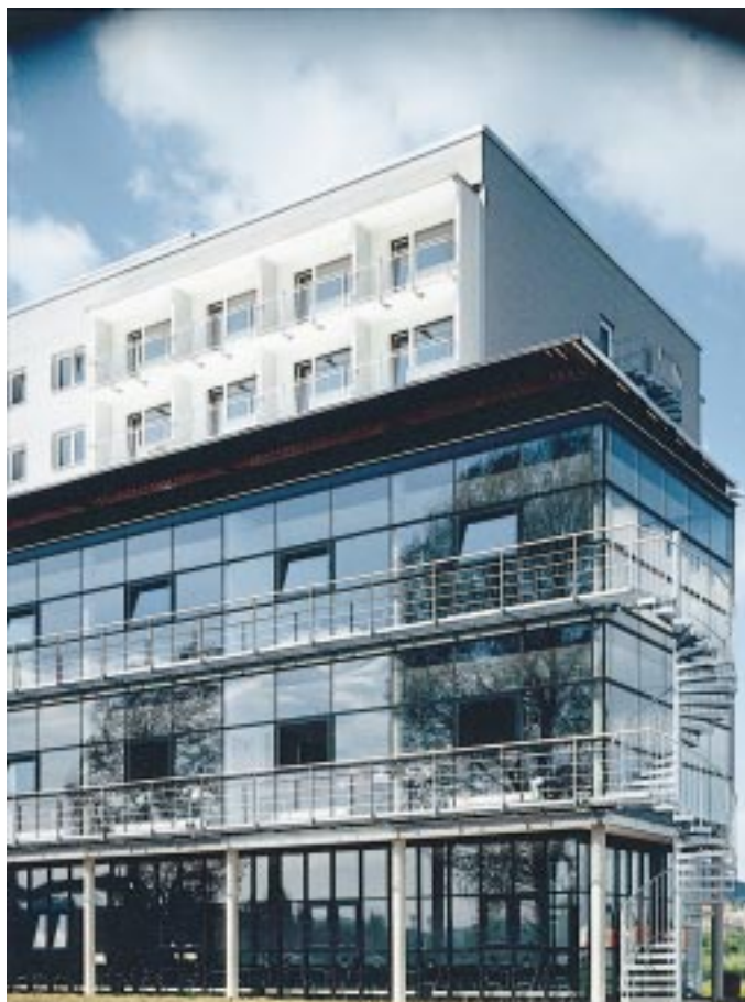
Ein filigranes Glas- kleid erhielt der Plattenbau der Zivildienstschule Sondershausen Foto: Glötzer
