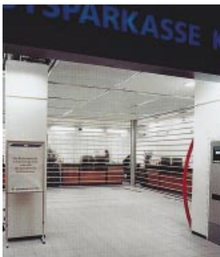
*Einbruchsicher und durchsichtig, das ist bei diesem prämierten Tor „Transparoll“ von der Guillaume Jansen BV kein Widerspruch, der Panzer besteht aus Aluminium und Streifen aus durchsichtigem Polycarbonat*
