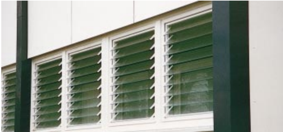
Die Schrägstellung der Glaslamellen wurde bewußt auf 45° fixiert Fotos: Schüt-Duis
