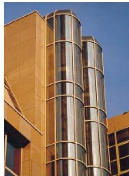
Dresdner Bank, Frankfurt: Isolierglas gebogen aus: „Calorex A 1“ (außen), Float 5 mm (innen), Kuppelscheiben aus „Calorex A 1“ und Verbundglas aus: 2 x Float 4 mm mit Gießharz 1,5 mm
