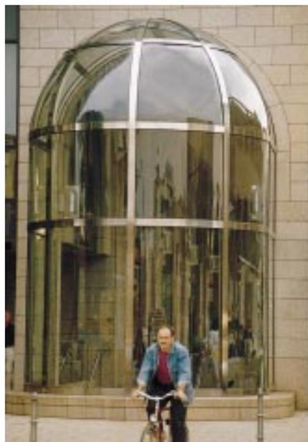
Eingangsbereich der Kreditanstalt für Wiederaufbau, Frankfurt: Isolierglas gebogen aus: 2 x Float 6 mm mit 0,76 mm Folie (unten); Isolierglas sphärisch gebogen aus: 2 x Float 6 mm mit 1,5 mm Gießharz (oben) Fotos: Freericks
