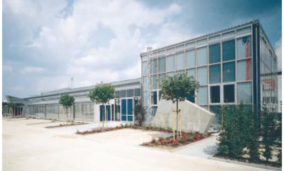
In dem Forschungs- und Entwicklungszentrum in Coburg sind 60 m 2 TWD-Module mit „Helioran“ eingebaut Foto und Grafik: Glaswerke Arnold
