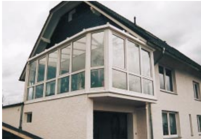
Bild 1: Ansicht des Wintergartens mit Garage
