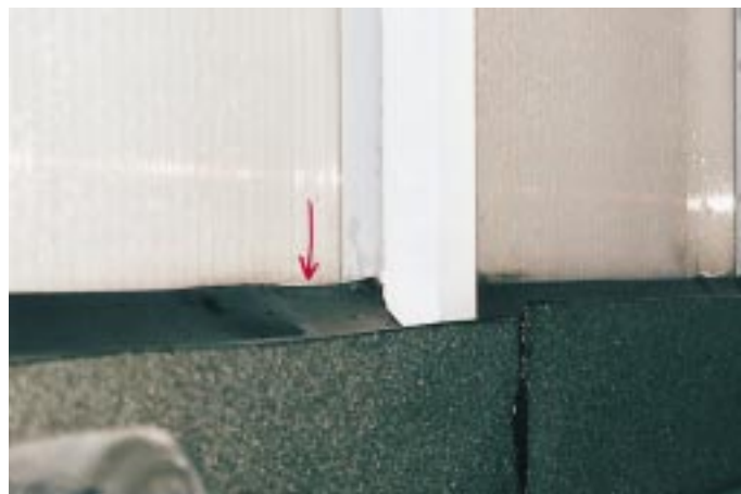
Bild 4: Unter dem Dichtungsprofil wird Wasser eingetrieben
