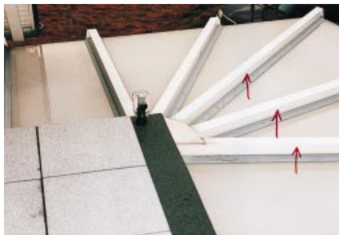
Bild 6: An diesen Stellen bildet sich Tauwasser
