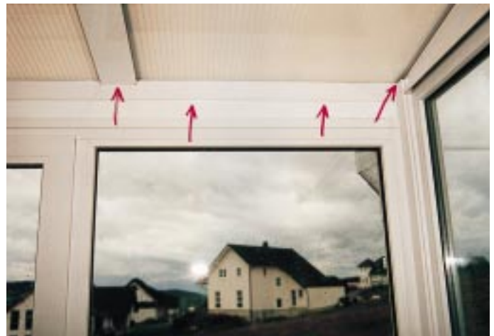
Bild 6: An diesen Stellen bildet sich Tauwasser
