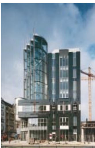
Referenzobjekt: Gebogenes Tambest-Verbandsicherheitsglas an der Frankfurter Allee in Berlin Foto: Tambest
