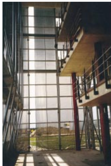
Bild 8: Die Westfassade des Kantoort Haans weist im Sommer einen Gesamtenergiedurchgang von nur 0,25 auf. Dieser ergibt sich aus einem Mittelwert der Glasanteile mit Lichtlenkungen und ohne Lichtlenkung
