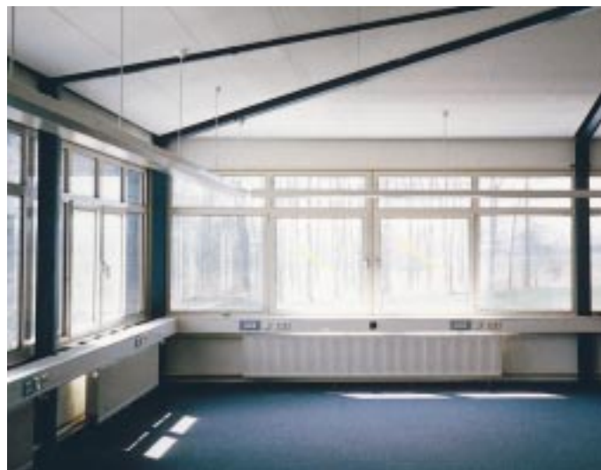
Bild 4: Die Oberlichtbereiche und die zwei seitlichen Fenster sind mit dem Köster-Solar-Glas als permanente Lichtlenk- und Sonnenschutzmaßnahme ausgerüstet. Vorteil: Besonders aus der Raumtiefe bleibt trotz der Lichtlenkung die Transparenz und Durchsichtigkeit erhalten
