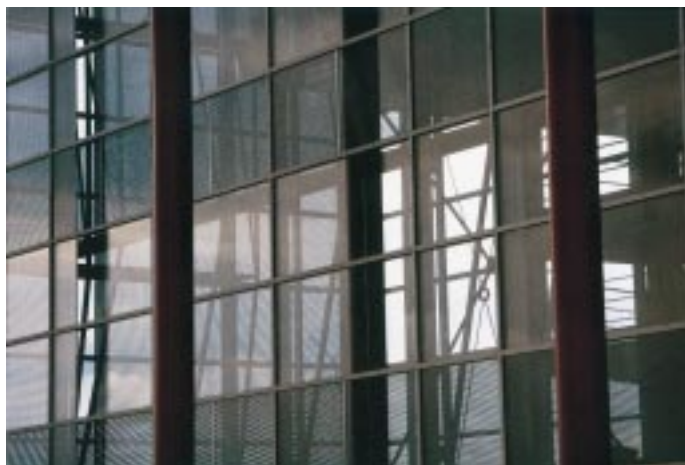
Bild 7: Die Fassade zeichnet sich durch eine besonders gute Transparenz aus
