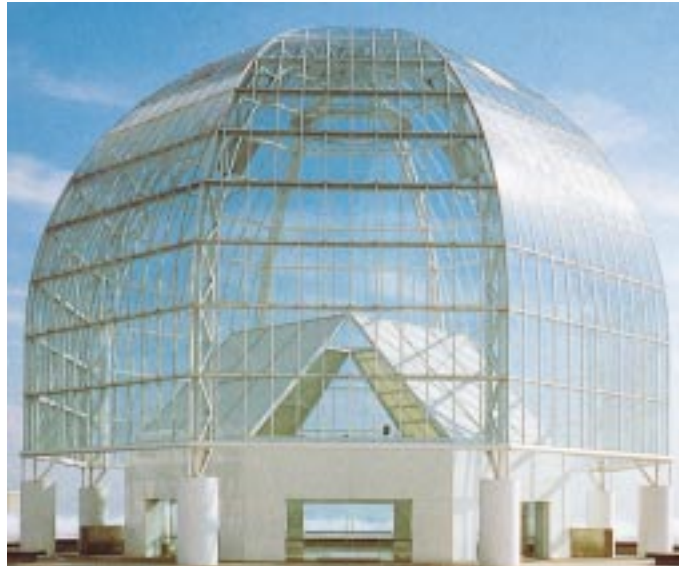
Structural Glazing, zweiseitig verklebt: Referenzobjekt der Wacker Chemie im Seaside Marine Park, Tokio Foto und Zeichnungen: Wacker Chemie
