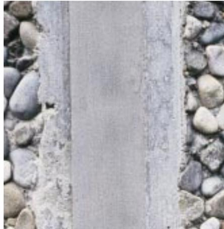
*Bild 1: Entsprechend DIN 18 540 ausgebildete und abgedichtete Außenwandfuge zwischen Betonfertigteilen mit geschlossenem Gefüge*
