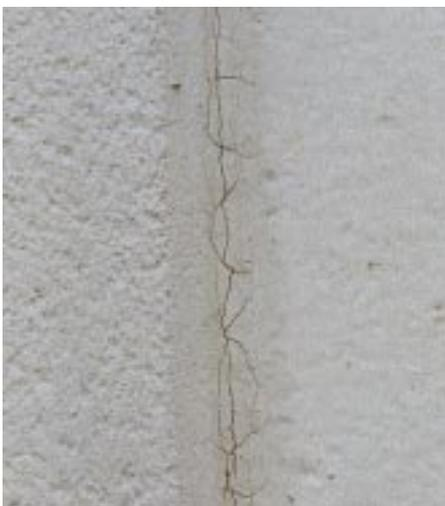
Bild 5: Diese Außenwandfläche aus Beton an einem Hochbau ist samt der Fugenoberflächen ganzflächig beschichtet worden. Nach einiger Zeit sind Risse im Anstrichfilm aufgetreten, die bis in den Dichtstoff hineinreichen
