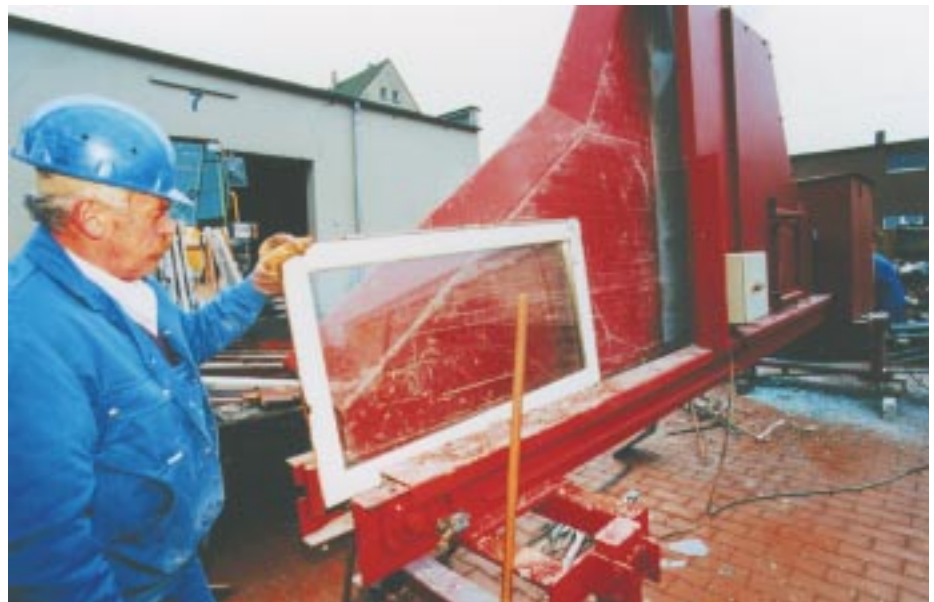
In Münster werden die alten Fenster demontiert
