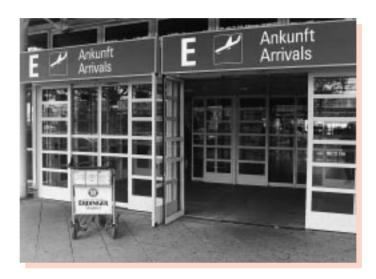
Automatiktüren, die nach dem Swing-Out-Prinzip funtionieren, lassen sich am Münchner Flughafen im Notfall einfach nach außen aufdrücken Foto: ats
