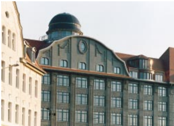
Auch bei der Althaus-Sanierung wird das Übereinstimmungszeichen vom Hersteller (ÜH-Zeichen) gefordert
