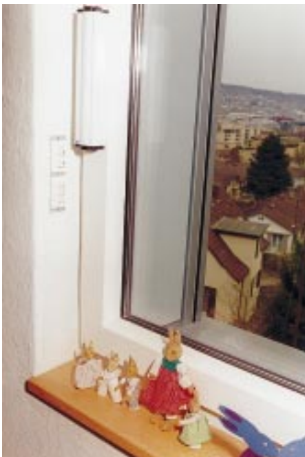
Detail eines elektrisch beheizbaren Fensterrahmens; oben: Stellmotor zum Öffnen; darunter: Schalter für Jalousie (außen liegend) und Öffnungsmotor Foto: Pfäffinger
