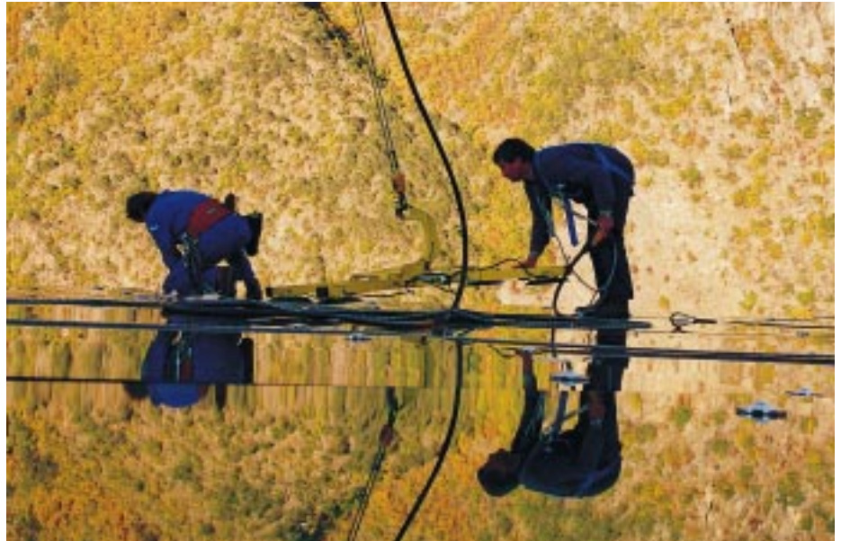
Montagearbeiten auf Schloß Juval
