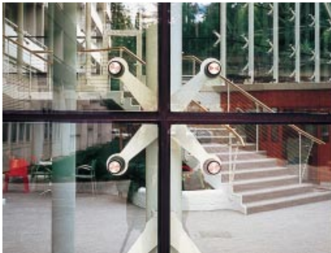
Detailaufnahme des Punkthaltesystems in der Fassade der Frankenklinik Fotos: Okalux Kapillarglas
