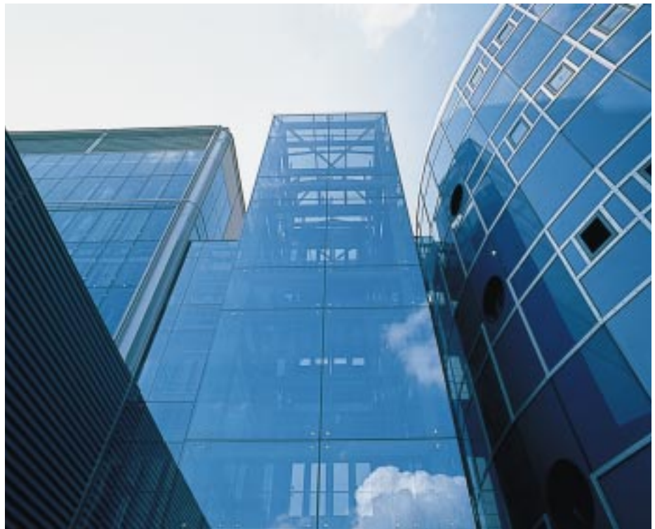
Das 1995 neugebaute Druckereigebäude der süddeutschen Regionalzeitung „Heilbronner Stimme“ ist fast vollständig in Glas gehüllt; das Besondere: Bauherr und Planer wünschten sich für die Verglasung einen Blauton, entsprechend dem hauseigenen Logo
