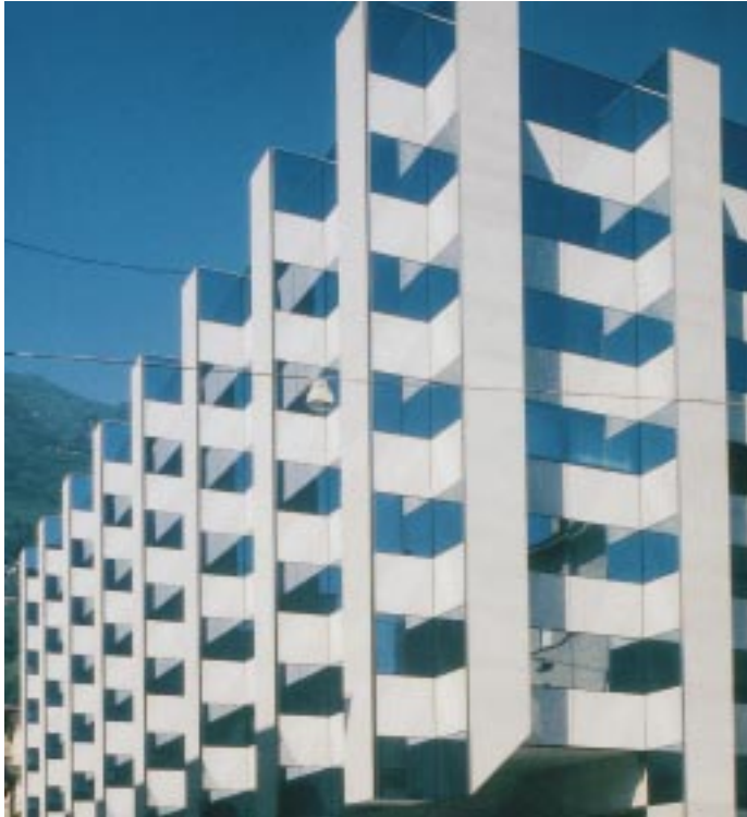
Die Fassadenpaneele „Linit“ aus Glas, Metall oder Holz bietet zugleich Wärme-, Schall- und Brandschutz Foto: Linzmeier
