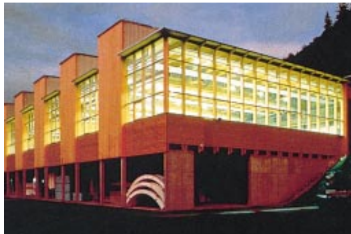
Fassadenbeispiel: Fachwerkträger aus Furnierstreifenholz
