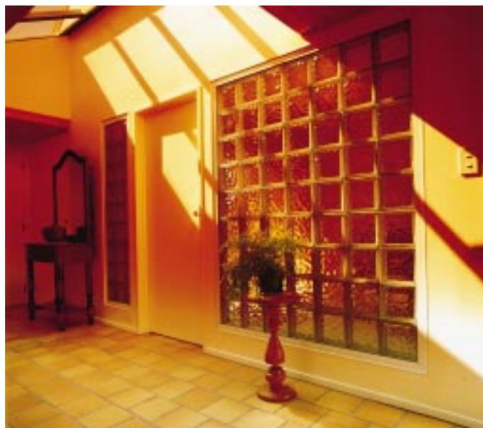
Steckfix-Glassteinsysteme empfehlen sich durch ihren schnellen und mörtellosen Aufbau
