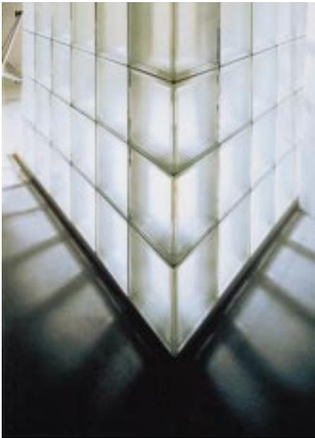
Das Eckelement mit einem 60°-Winkel am Beispiel des Solaris-Glassteins „Riva“
