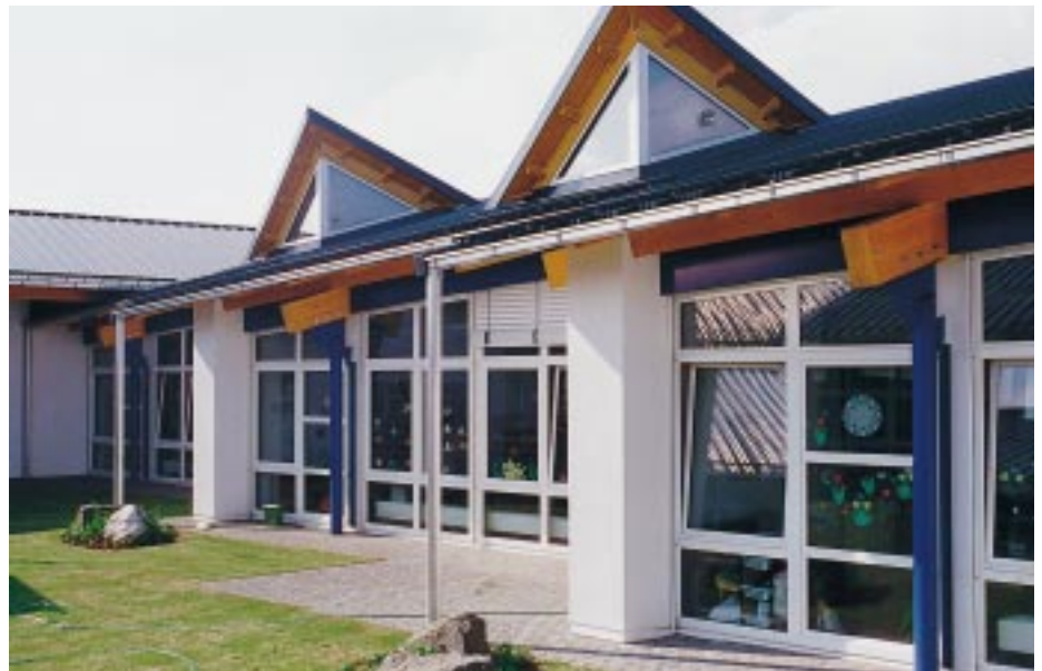
Die Grundschule in Simmern mit den Holz-Alu-Fenstern
