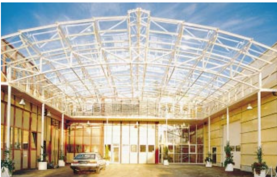
Dieses Glasdach verbindet zwei Produktionshallen der Firma Glasmetall Meusburger in Lustenau Fotos: Meusburger
