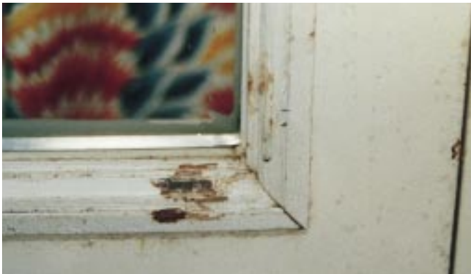
Der Schadensfall: Keine Konstruktion nach deutschen Standards
