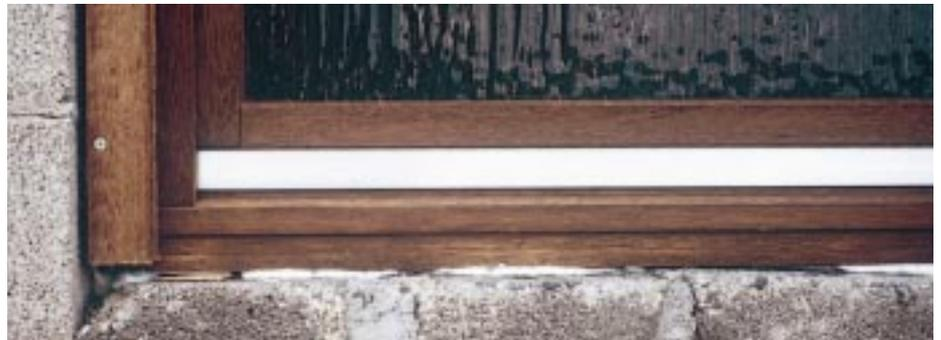
*Eine zu schmale Fuge, in die keine Dämmmaterialien eingebracht werden können*
