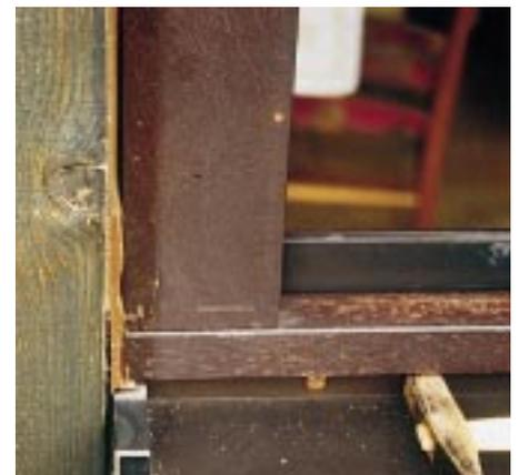
*Abriß der Baukörperanschlußfuge wegen einer Unterdimensionierung des Fugenquerschnittes und fehlender Hinterfüllung*
