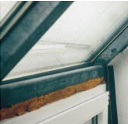
*Eine zu breite Fuge, bei der die Ausschäumung nicht ausreichend ist, um eine dauerhafte Abdichtung zu gewähren*
