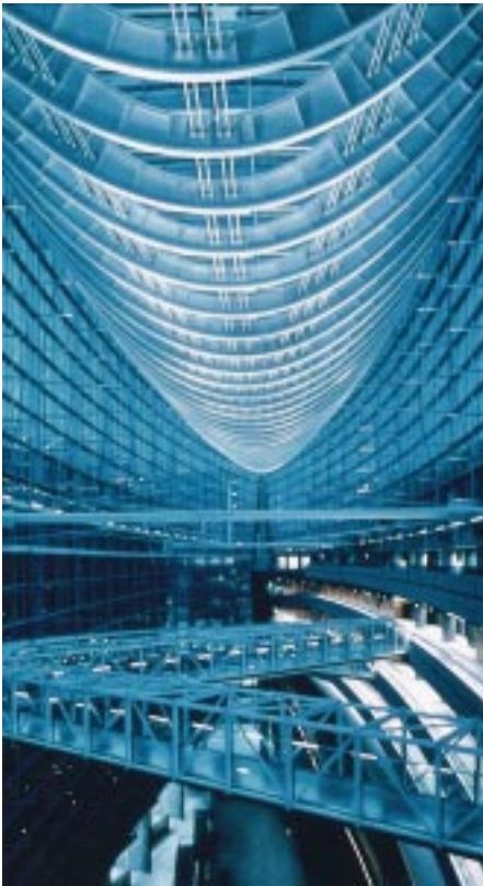
In der riesigen Glashalle des Tokyo International Forum senkt sich die vorgehängte Wandverkleidung aus Verbundglas wie ein transparenter Vorhang von der Trägerkonstruktion der Decke herab und begrenzt damit den Innenraum
