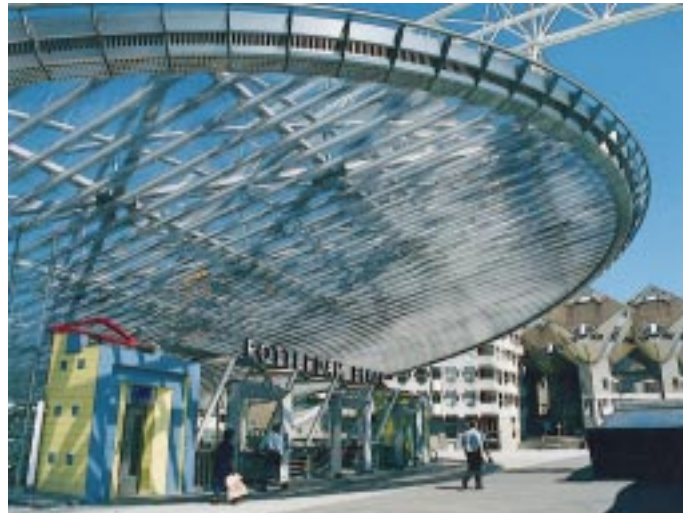
„Lexan Exell-D“ eignet sich für eine Vielzahl von Außenanwendungen, wie das Beispiel des Bahnhofs in Rotterdam Blaak zeigt Foto: GE Plastics
