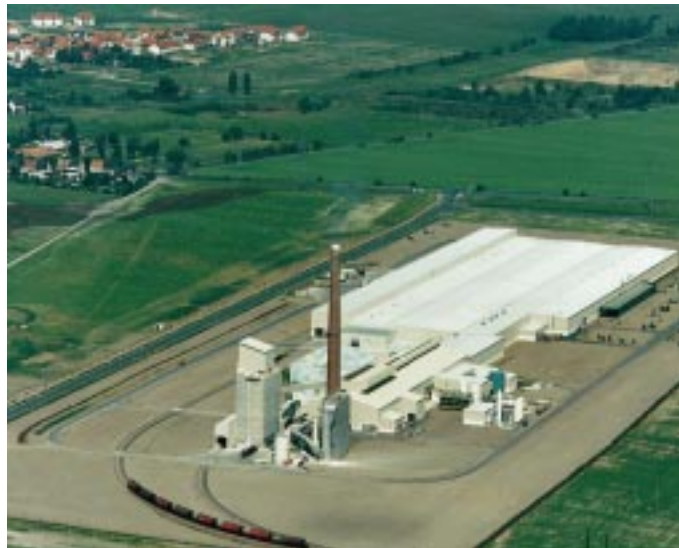
Der Standort: Rund 23 ha groß ist das Areal der Guardian Flachglas GmbH in Wolfen-Thalheim
