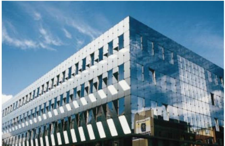
Das Verwaltungsgebäude der Firma Rosenthal in Selb hat Kalt- und Warm-Fassadenteile mit mechanischer Sicherung
