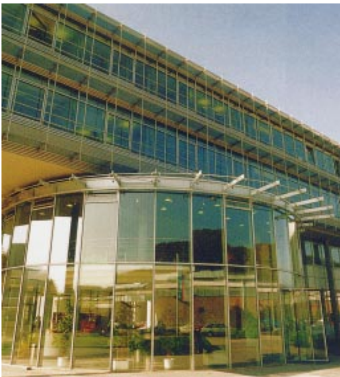
Lichtdurchflutet: das neue Siegenia-Verwaltungsgebäude Foto: Siegenia
