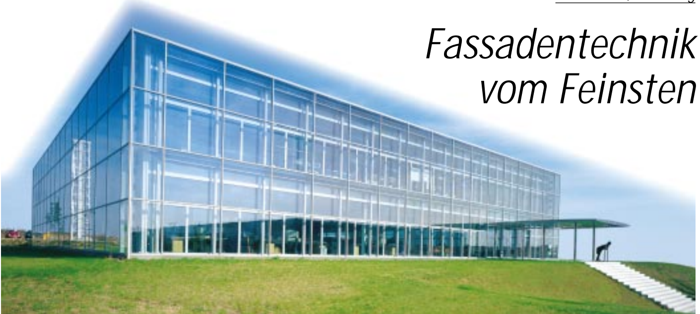
Gesamtansicht Südseite mit Eingang
