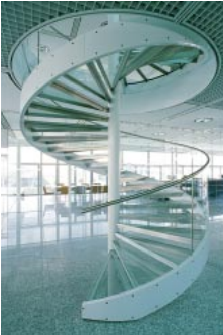
Glastreppen mit „Sanco Safe“
