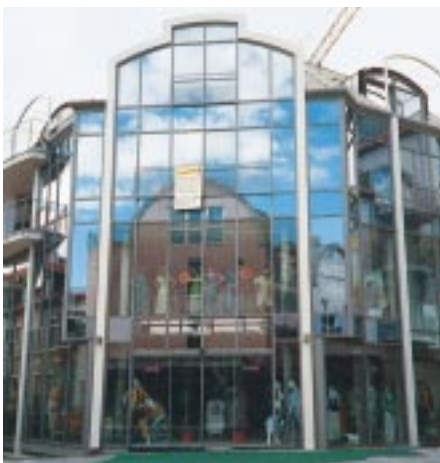
Architektonische Akzente: Die „FW Glasfassade PR60“ mit integrierten Drehkipp-Fenstern und Balkontüren am Wohn- und Geschäftshaus Herb in Frankenthal
