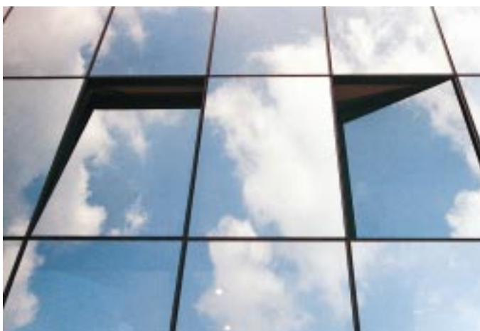
Ausschnitt einer „FW Glasfassade SG“ mit zwei Drehkippfenstern bei Mercedes-Benz in Michelstadt
