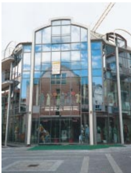
„FW Glasfassade PR60“ mit integrierten Drehkipp-Fenstern und Balkontüren am Wohn- und Geschäftshaus Herb in Frankenthal
