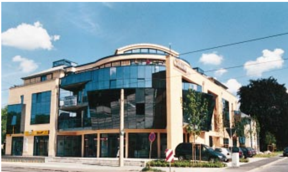
„FW Glasfassade SG“ mit integrierten Kippfenstern im segmentiert geneigten Bereich sowie Drehkipp-Fenstern im Erker und in den segmentierten Fassadenteilen an einem Geschäftshaus in Radebeul
