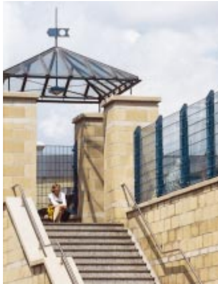
Schallschutz: Die gläserne Wand zwischen Rastanlage und dem Stadtrand von Helmstedt verschafft Autobahnwohnern Ruhe
