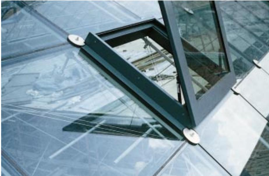
deckter Weise. An den blockförmigen Verbindungsknoten der Tragwerksstäbe werden auch die durchlaufenden, vorgespannte Seildiagonalen mit Klemmtellern befestigt.
