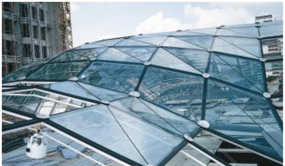
Bild 4: Oberhalb der Einmündungen von Seitenstraßen sind die Tonnengewölbe kuppelartig miteinander verschnitten; die Krümmung verkräftet ggf. auch thermische Längsänderungen des Tragwerks
