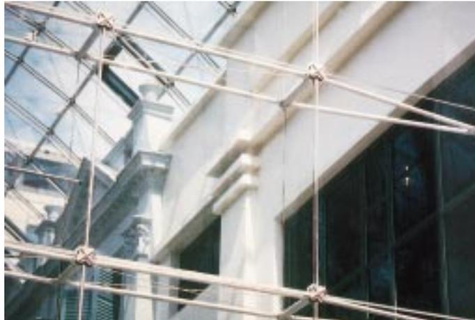
Bild 2: Die Einkaufspassagen der „Bugis-Kreuzung“ in Singapur beherbergen ca. 200 Läden unter verglasten, feuerverzinkten, stählernen Gitternetz-Gewölben (mit kuppelartigen Überlappungen), die als Klimahülle ganzer Straßenzüge wirken
