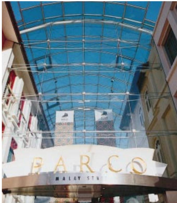
mit speziellen „Butterfly“-Haltern an ihren Eckpunkten gestützt. Die Verfügung erfolgte gleichfalls mit Silikon, um auch hier die hervorragende Transparenz der Glaskonstruktion zu erhalten.
