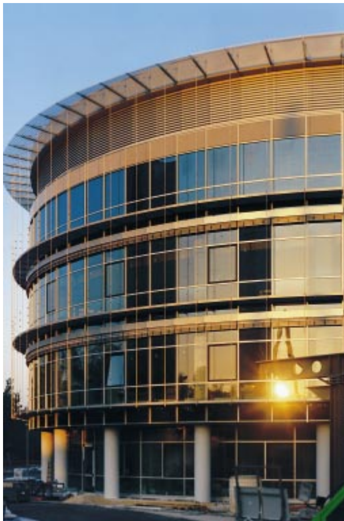
Fassade Westflügel Messe Nürnberg
