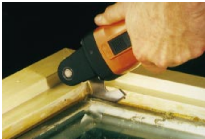
Schnell und sicher bei der Isolierglas-Sanierung: der Fein Schneider „FSN 400 E“
