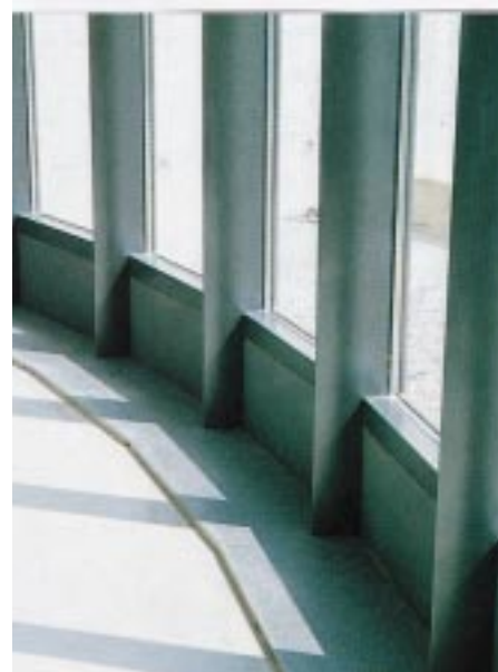
Das pfeilförmige Hohlprofil „Viss-Delta“ ermöglicht eine schlanke Fassadengestaltung
