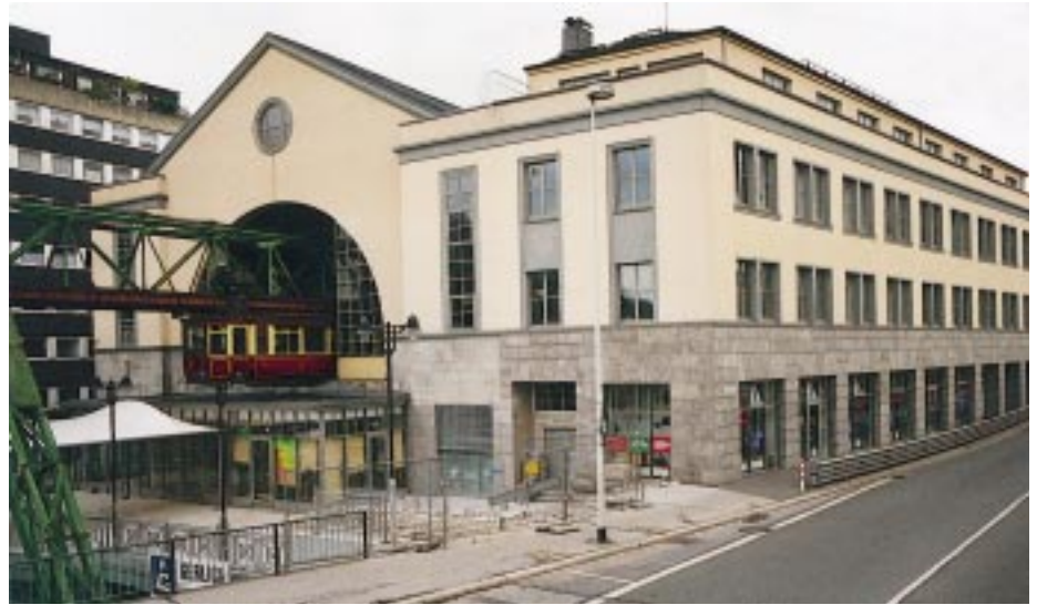
Bahnhof „Döppersberg“ mit angrenzendem „Köbo-Haus“
