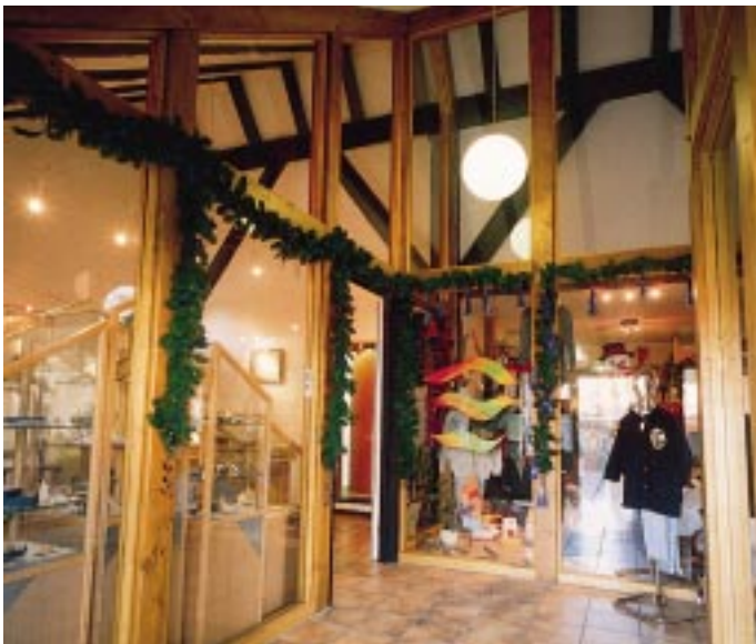
„Pyranova“ F 30 feuerhemmendes Glas im Holzrah- men verhindert Feuer- und Hitze- durchtritt in die Rettungsflure des Ladenzentrums
