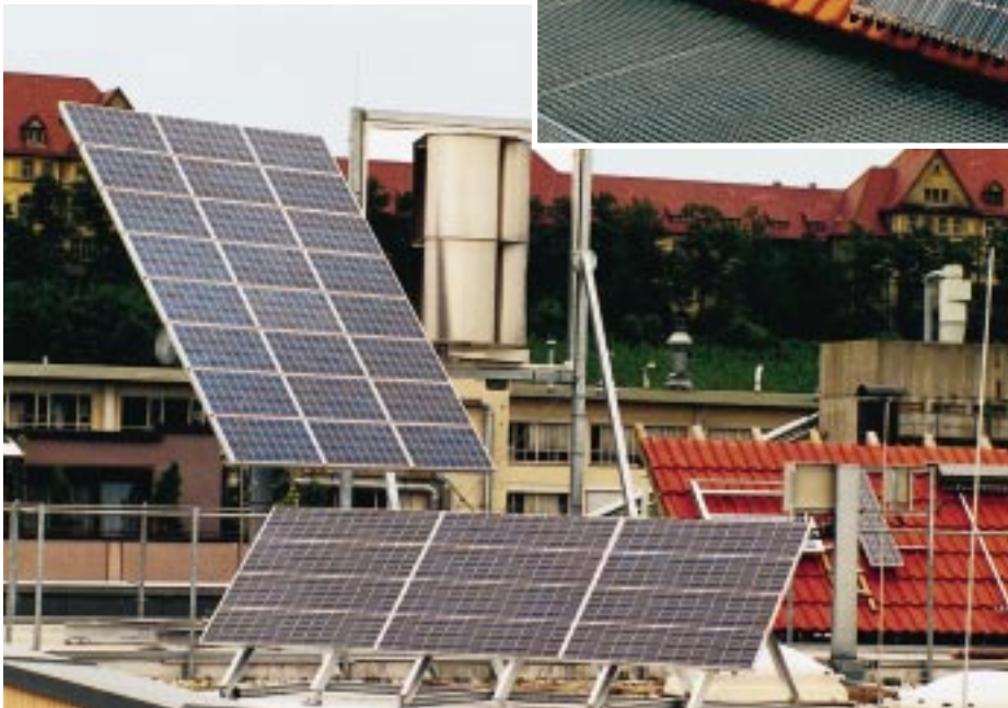
Zum Montagedach des Solarenergie-Zentrums gehören Photovoltaik-Module, Röhrenkollektor und eine Windkraftanlage
