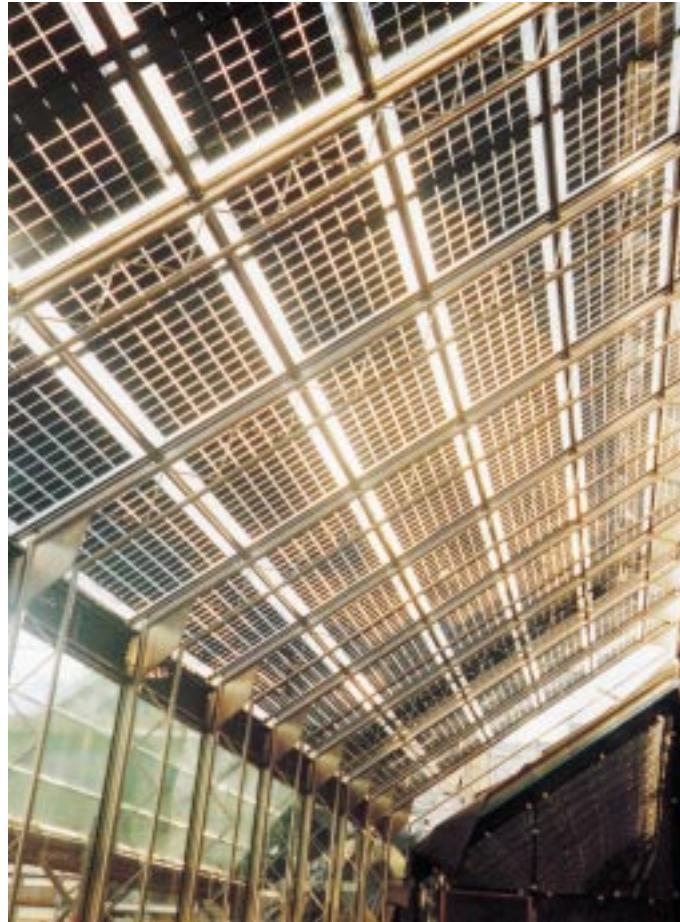
Hallendach Bayerische Landesbank, München: „Prosol“-Solarmodule für Lichtdächer gemäß Überkopfrichtlinie Fotos: Vegla
