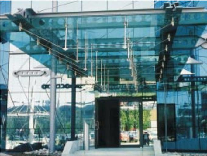
*Punktgestützte, unterspannte Vordachverglasung eines Verwaltungsgebäudes*
