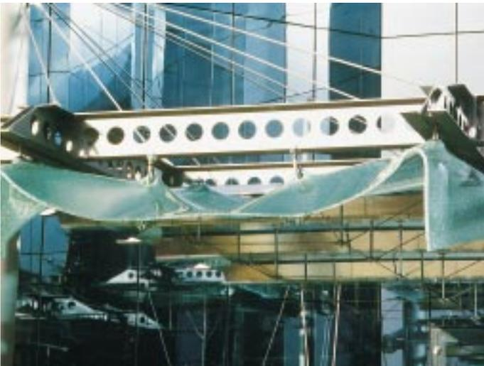
*Schadensbild des Vordachs bei Ausführung VSG aus ESG, verursacht durch Anstoßen eines Lkw an die Unterspannung*
