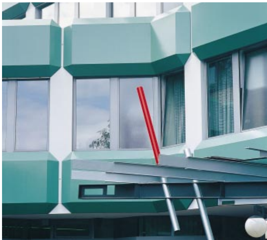
Zeitgemäß und umweltgerecht sanierte Fassade
