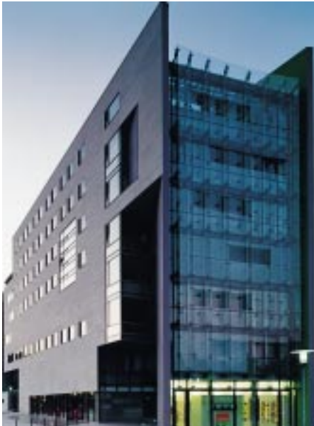
Bild 2: Vorsatzfassade (Platzseite) des MediaParks in Köln, Gebäude Block 2
