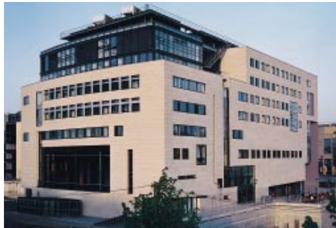
Bild 1: Der Gebäudekomplex Block 2 in der Rückansicht
