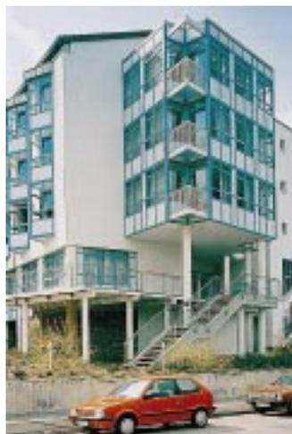
Die Mehrschichten-Verbundplatten können in den verschiedensten Bereichen eingesetzt werden, z. B. als Fensterbrüstungselemente
