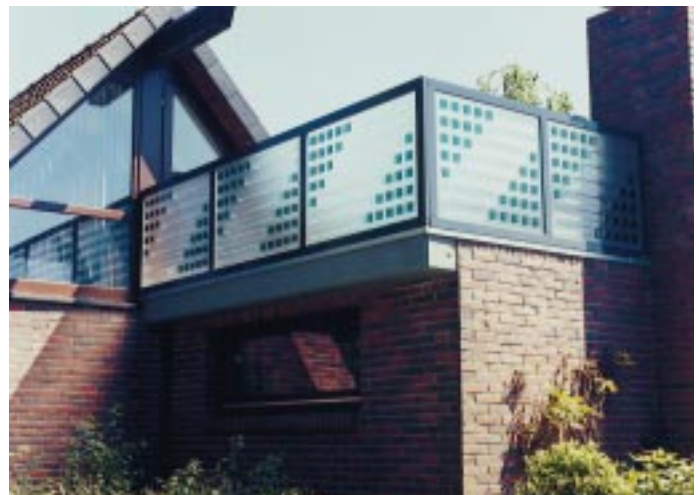
Ein weiteres Anwendungsgebiet für großflächiges Glas-Fusing zeigen die Neuenburger Glaswerkstätten unter der Leitung von Werner Koch. Die „WKB“-Balkonbrüstungen sind im Fusing-Verfahren hergestellt und garantieren Farb- und Alterungsbeständigkeit. Sicherheit für Personen und Bruchfestigkeit für das Produkt selbst wird durch die Verarbeitung der Glas-Fusing-Elemente mittels Lamellierung auf ESG erreicht. Die Glasgestaltung bietet eine enorme Farben- und Formenvielfalt. Das Verfahren eignet sich für Unikate ebenso wie für Kleinserien. Die maximale Elementgröße beträgt derzeit 900 x 1800 mm. Die „WKB“-Balkonbrüstungen können einerseits in Rahmen gehalten, aber auch rahmenlos montiert werden. Foto: Neuenburger Glaswerkstätten
