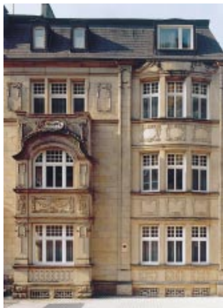
Stilgerechte Fenster-Renovierung mit Kunststoff (Schüco)
