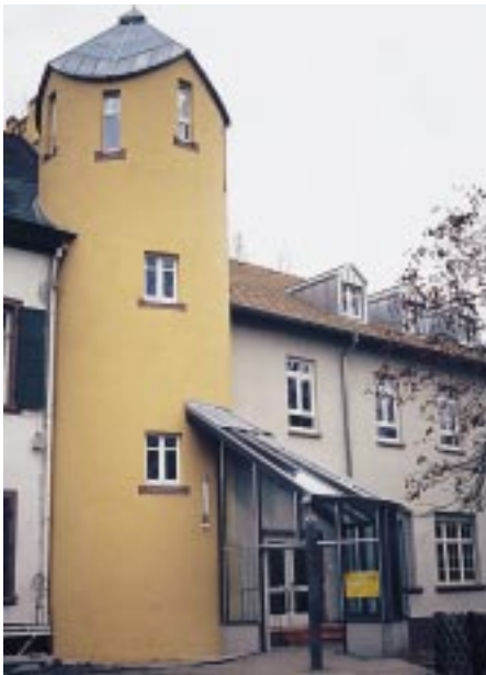
Schloß Ardeck mit ergänztem Treppenturm und saniertem Kindergarten
