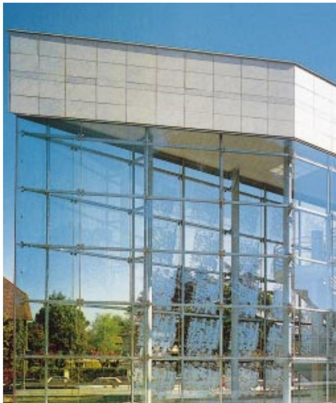
Phantasievolle Fassade: „Artlite“-Glaselemente mit hoher mechanischer Widerstandskraft
