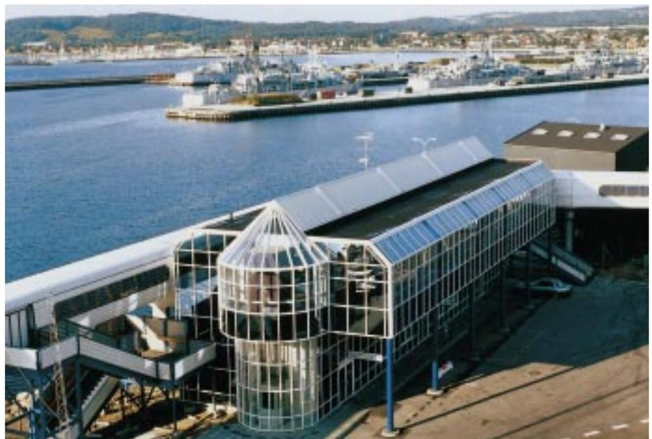
Sicherlich eines der beeindruckendsten Bauvorhaben, das mit einem Kunststoff-Fassadensystem erstellt worden ist, ist die Sanierung des Serviceterminal der Larvik Line im dänischen Frederikshavn. Das bestehende zweistöckige Abfertigungsgebäude wurde um ein Stockwerk erweitert und vollständig mit Fassade überbaut. Um die Architektur abzurunden ist auf der Stirnseite des Gebäudes eine turmartige Rundfassade mit zwei unterschiedlichen Radien ausgeführt. Die Räume sind großzügig und lichtdurchflutet
