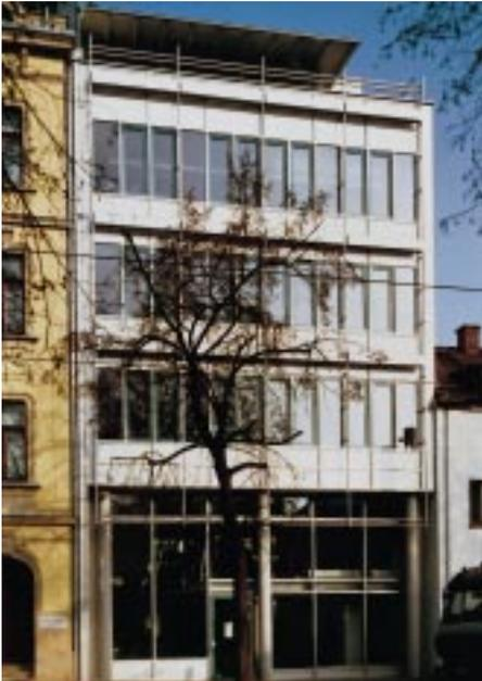
Bei dem Bürogebäude in Plauen sind die gesamten Außenflächen, einschließlich des Penthouses im Fassadensystem ausgeführt. In den verglasten Feldern der drei oberen Stockwerke wechseln sich jeweils zwei Dreh-Kipp-Flügel mit einer Festverglasung ab. Die Farbe der Blend- und Flügelrahmen sind der Farbe der Verglasung angepaßt. Mit einigem Abstand vom Gebäude sind die Rahmen nicht mehr erkennbar
