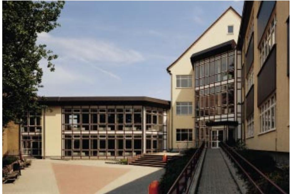
Bei der Sanierung des Geschwister-Scholl-Gymnasium in Sangershausen wurden die Abdeckleisten der Pfosten und Riegel in dunkelrot gehalten, um einen schlanken Eindruck der Konstruktion zu schaffen. Als transparente Füllungen sind festverglaste Elemente abwechselnd mit Kipp- bzw. Dreh-Kipp-Flügel eingesetzt. Die Fassadenteilung wirkt sehr verspielt und lockert die schlichten Außenansichten des Schulgebäudes gelungen auf
