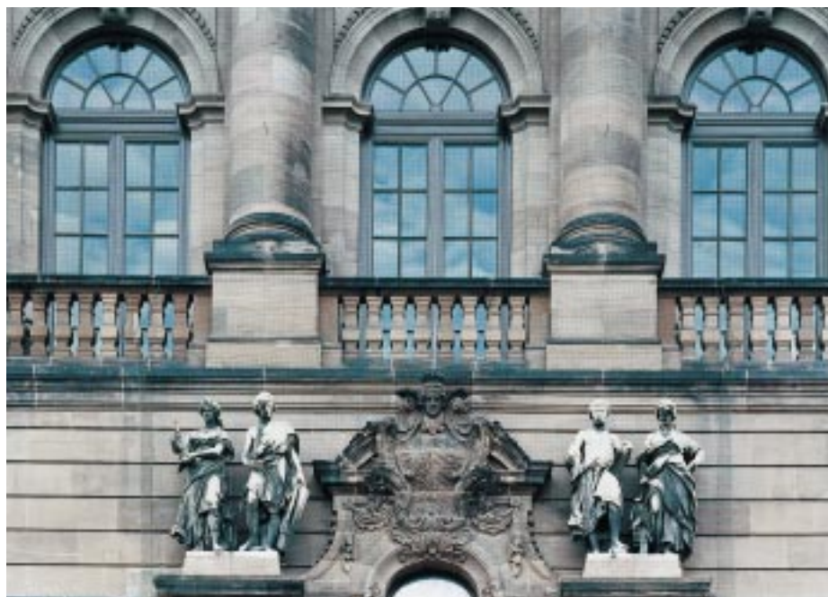
Außenansicht der neobarocken Fassade der Nürnberger Akademie: die Farbe der Fassadenfenster – aus RAL-Tönen speziell angemischt – fügt sich harmonisch in die Farbgebung der Sandsteine
