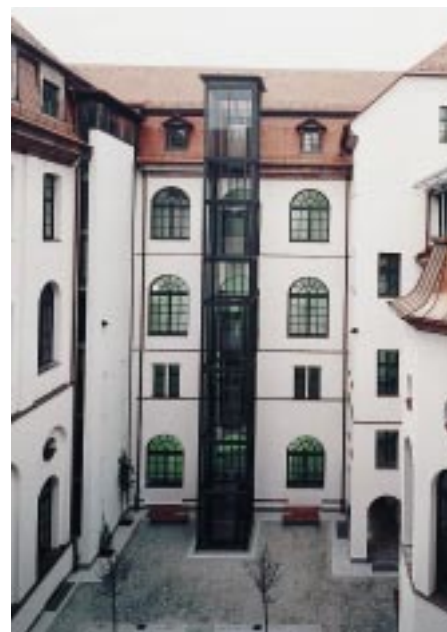
Die „Reynotherm RT 800“-Profile betonen die sachliche Gestaltung des Innenhofs
