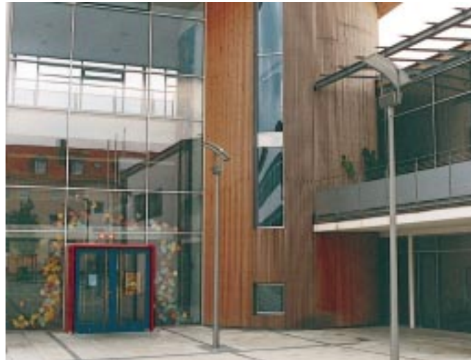
Eingangsanlage einer Schule mit Glasflächen, die von außen von Personen berührt werden können
